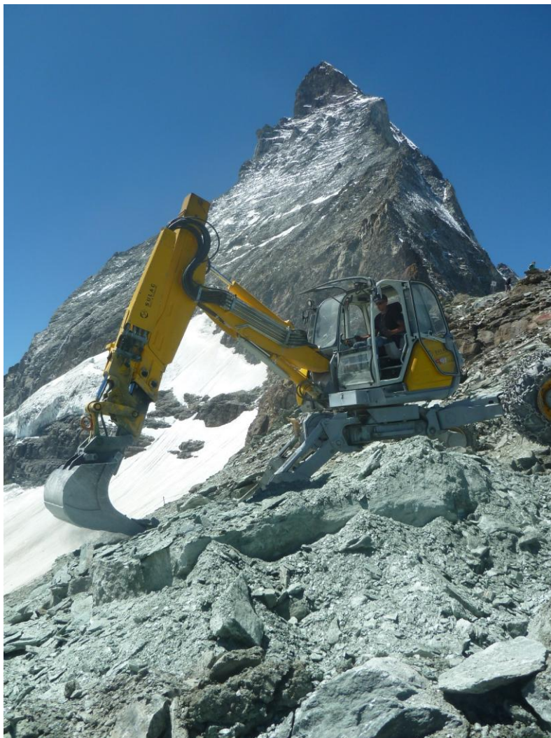
Felsabtrag für Erweiterung der Hörnlihütte (Quelle: Ulrich Burchard).
