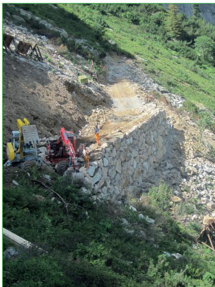
Abbildung 11: Fertigstellungsarbeiten am Schutzdamm. Foto: IG Teufelsstein.
