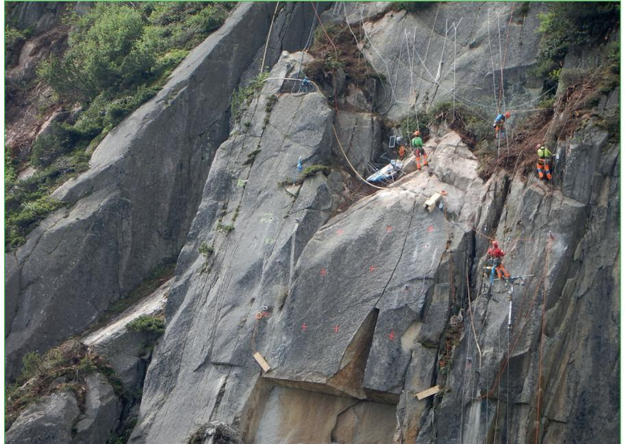
Abbildung 7: Ausführung der Erstsicherungsmassnahmen im Kopfbereich der Ablösezone. Foto: Gasser Felstechnik AG.
