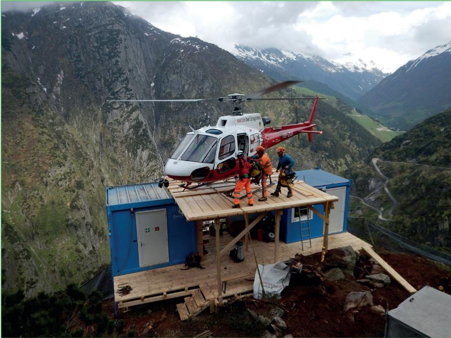
Abbildung 13: Die Baustelleninstallationen und Personentransporte im schwierigen und exponierten Gelände erfolgten per Helikopter mit eingeschränktem Flugkorridor aufgrund der bestehenden Hochspannungsleitungen. Foto: Gasser Felstechnik AG.
