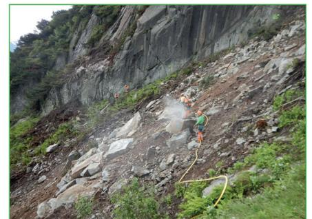
Abbildung 9: Zerkleinerung und Abtrag von Blockmaterial im Sturzperimeter. Foto: IG Teufelsstein.
